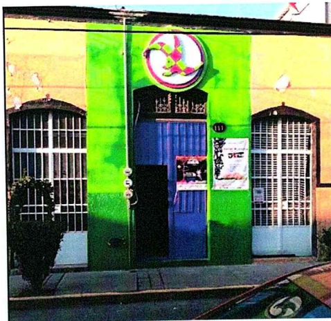
Fotografía de fachada
