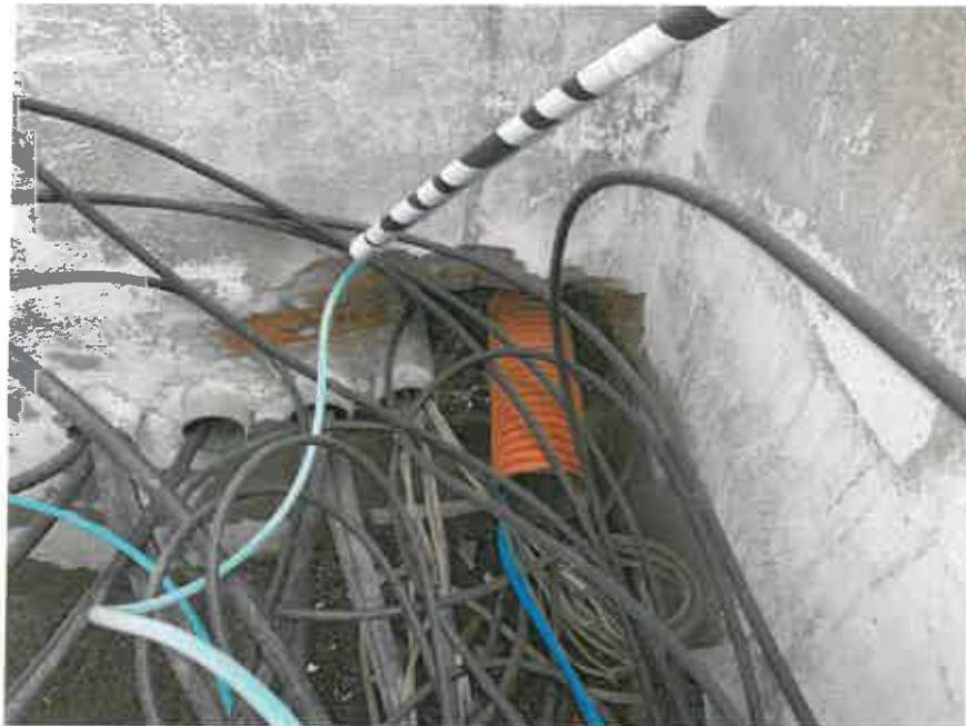
**Ductos saturados de tubos de fibra óptica**
