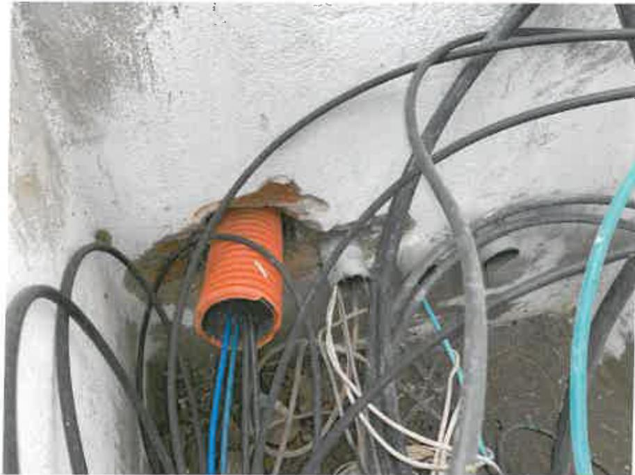
Ductos saturados de tubos de fibra óptica
