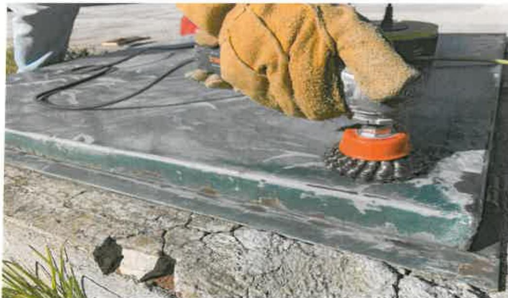
Se lijan las tapas para protección de la corrosión
