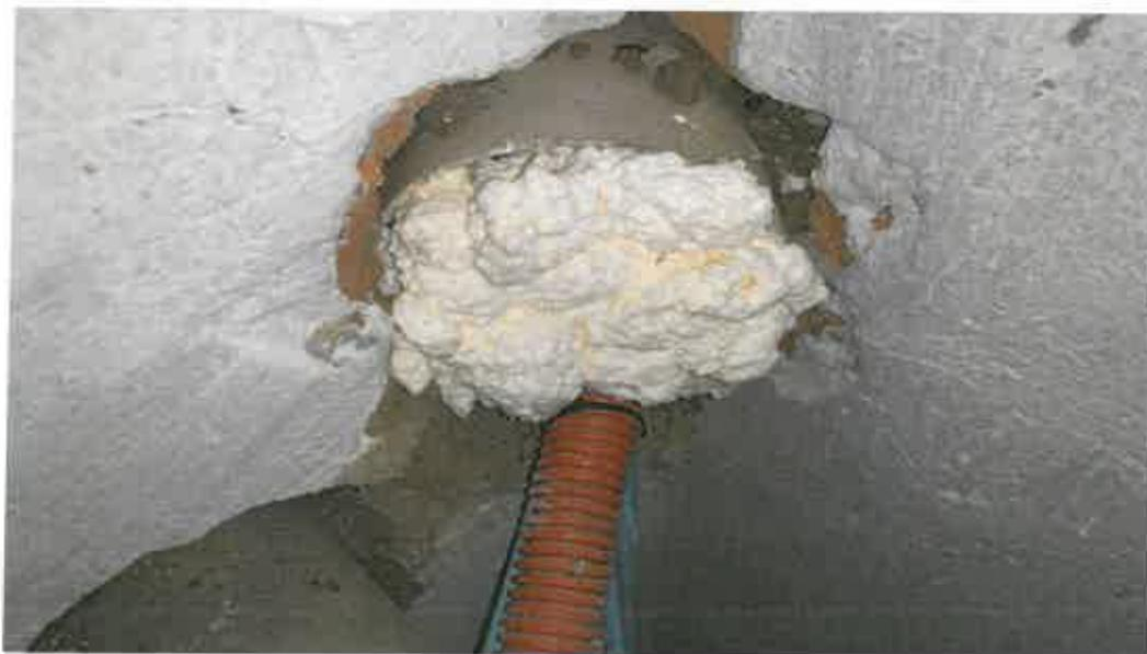
Sellado de los ductos con espuma expansiva poliuretano
