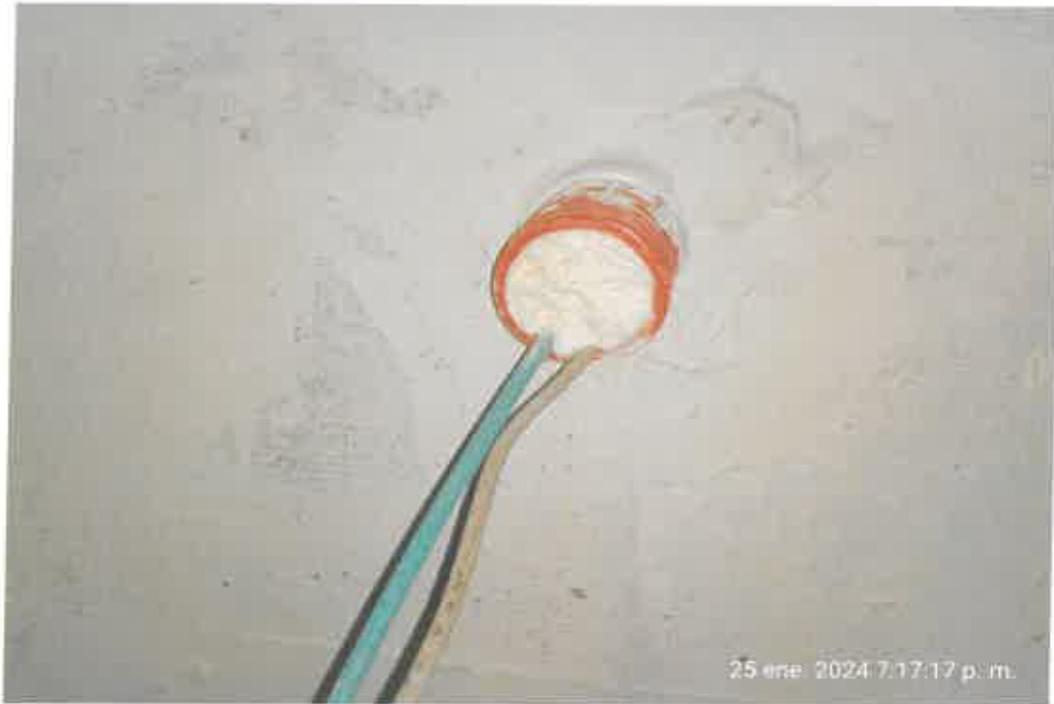
Sellado de los ductos con espuma expansiva poliuretano
