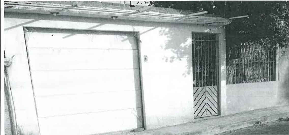
Fotografía de fachada
