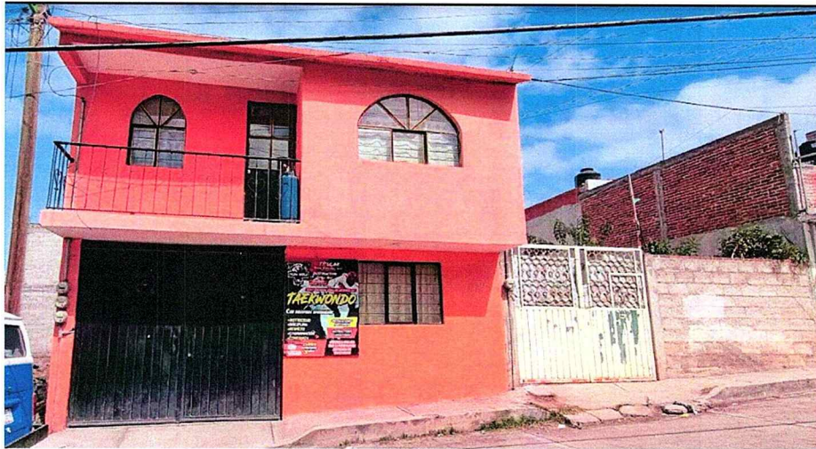
Fotografía de fachada
