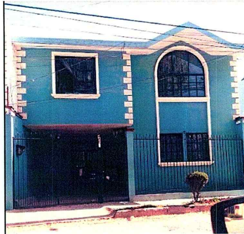
Fotografía de fachada
