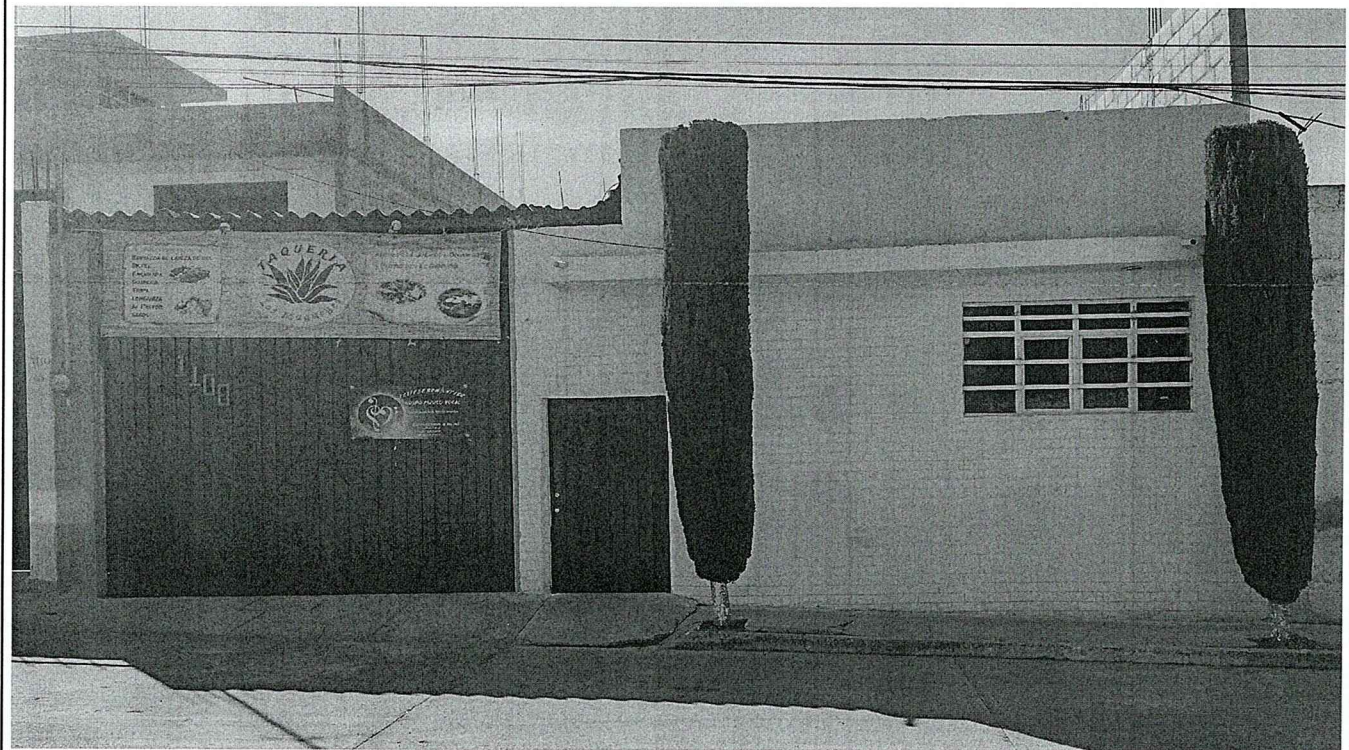
Fotografía de fachada
